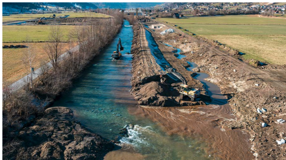
Bestehender begradigter Verlauf der Mur mit der bereits in Bau befindlichen Aufweitung (Blickrichtung flussaufwärts)
